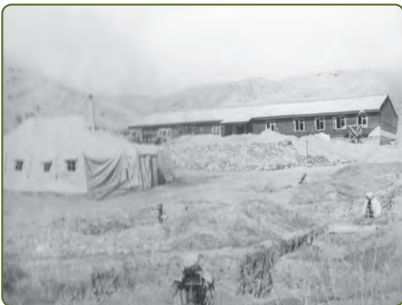
Строительство пограничной заставы «Саригоры» 117-го Московского пограничного отряда
